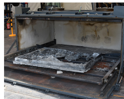
HV Bat-Box mit ausgebrann- ter Auto-Batterie
