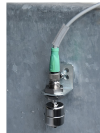
Schwimmschalter stoppt Befüllung
