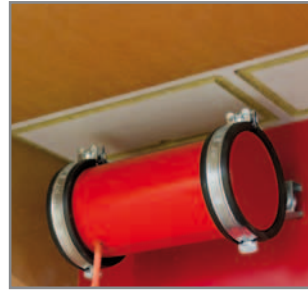
Brandunterdrückungssystem Stromunabhängige Auslösung bei Feuer und unzulässiger Temperaturerhöhung.
